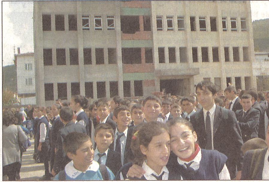
Kayışdağı mahallesindeki Celal Yardımcı İlköğretim Okulu'nun ek bina inşaatı öğrenciler için tehlike yaratıyor. Veliler ise çocukları için tedirgin olduklarını belirtiyor.
